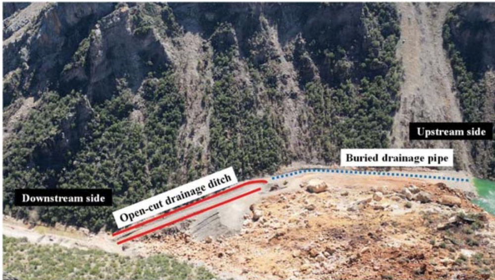
Şekil 9: Heyelan barajına inşa edilen taşkın savağı
