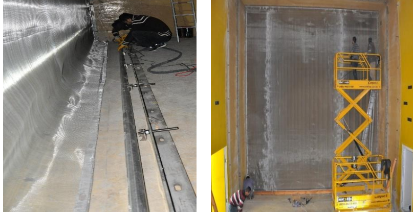
Şekil 9. Perdelerin Gerdirilmesi ve Montajı
